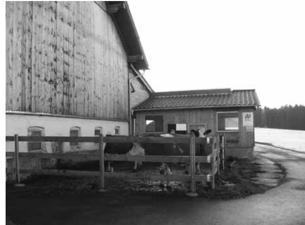
Kostengünstige Lösung: Anbau einer Liegehalle mit Auslauf
