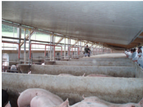
Abb. 8: Die Buchten im Pigport lassen sich bei Kälte durch eine in der Höhe verstellbare Platte abdecken (hintere Buchten abgedeckt, vordere offen) (Foto: Michael Götz)
