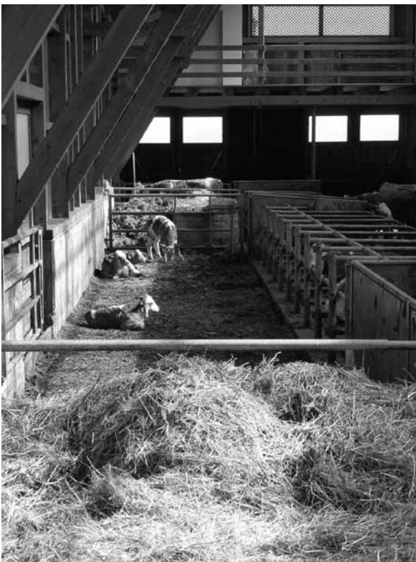
Großzügig bemessener Kälberbereich zwischen Boxenreihe und Stallwand, der auch mit dem Traktor entmistet werden kann
