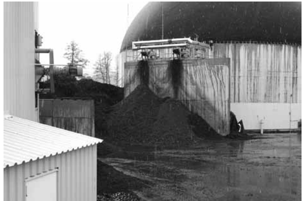
Anlage zur Fest-Flüssig-Trennung von Gärresten
